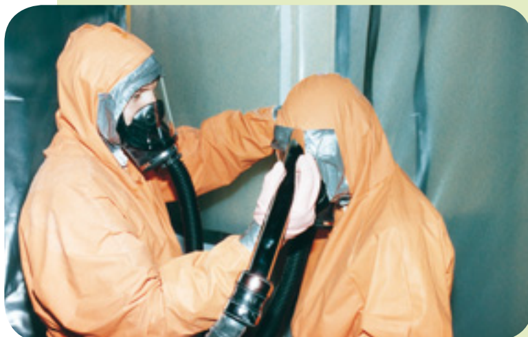
Dans la zone de récupération, les opérateurs dépoussièrent leur tenue de travail par aspiration
