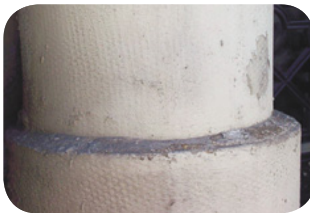
Conduite en amiante-ciment à l'intérieur d'un local
