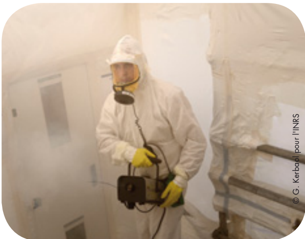
Test de fumée à l'intérieur du confinement.
