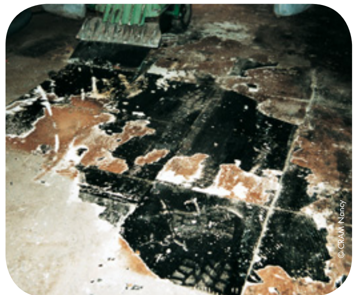
Décollement des dalles à la machine par réchauffage
