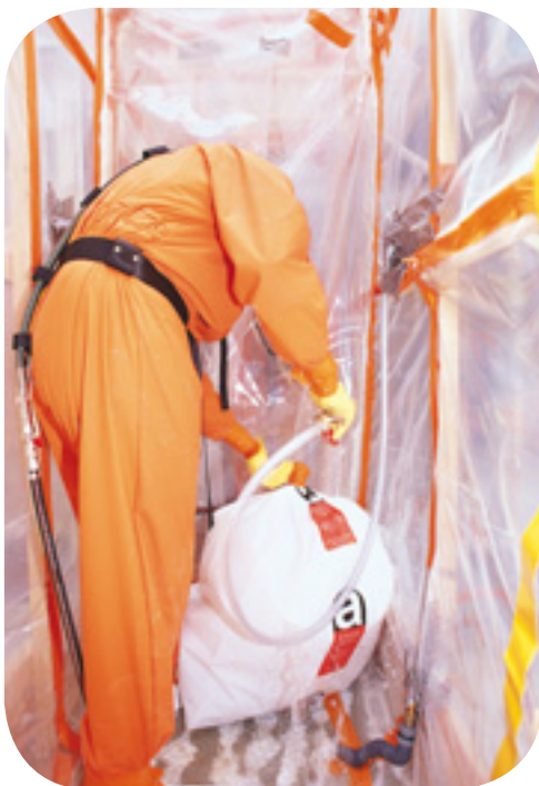
Le sac de déchets, étanche, fermé et marqué, est douché avant sa sortie de zone.
