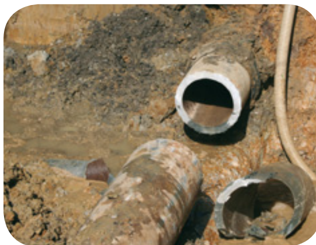
Canalisations en amiante-ciment.
