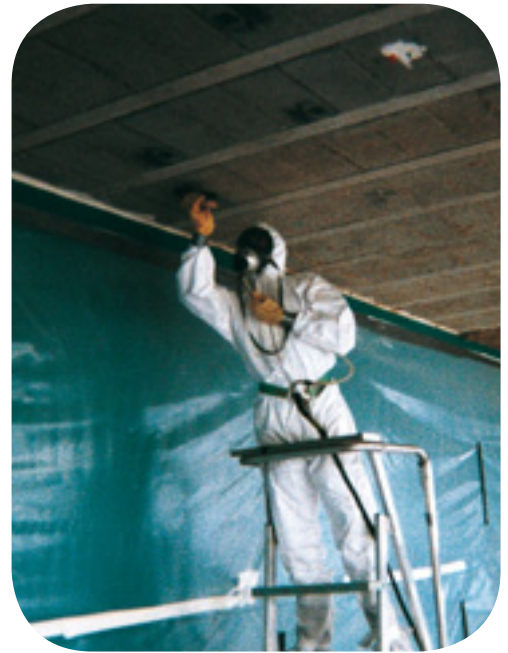
Travail de finition sur une nacelle mobile.
