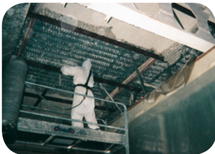
Retrait d'un enduit plâtreux projeté.
