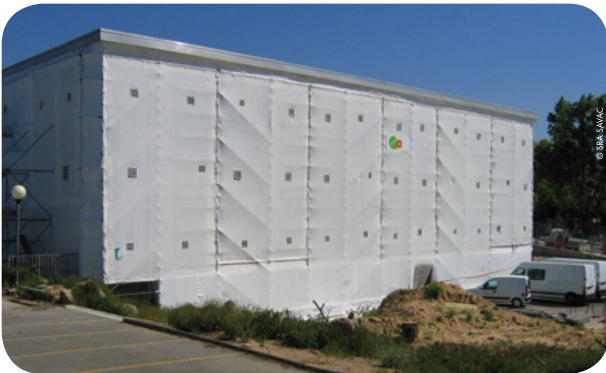
Confinement total d'un bâtiment.
