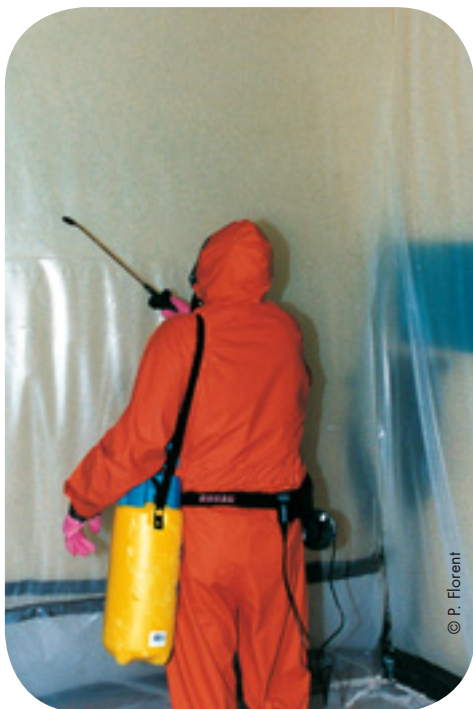
Application d'un surfactant sur les films.
