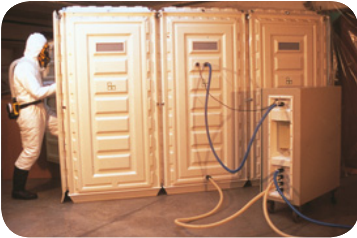
Tunnel à trois compartiments avec son chauffe-eau pour la douche.
