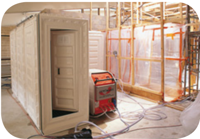
Le tunnel constitue l'unique accès du personnel à la zone contaminée.
