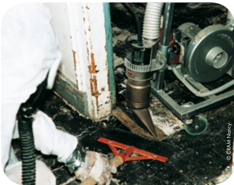
Décollement des dalles à la spatule.
