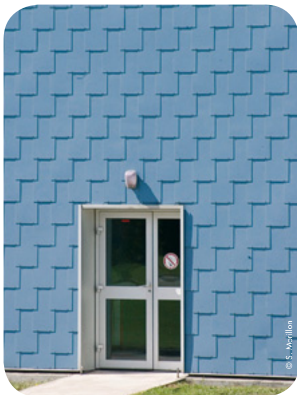
Bardage en amiante-ciment.
