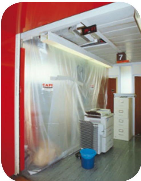
Confinement partiel avant nettoyage et évacuation des matériels.
