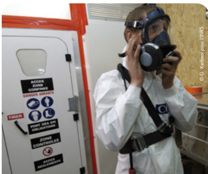
Un balisage clair est mis en place à l'entrée du tunnel d'accès à la zone.
