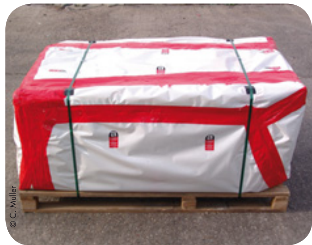
Emballage de plaques d'amiante-ciment sur palette
