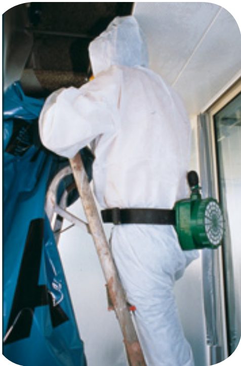
Appareil filtrant à ventilation assistée porté à la ceinture.
