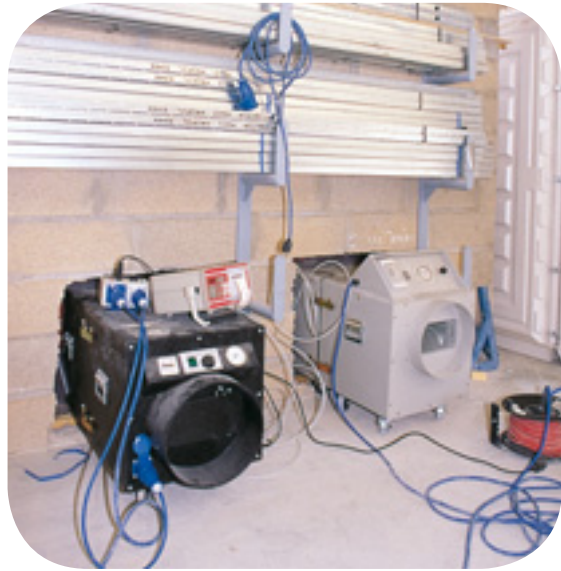
Extraction de l'air filtré et dispositif externe de contrôle de la dépression.
