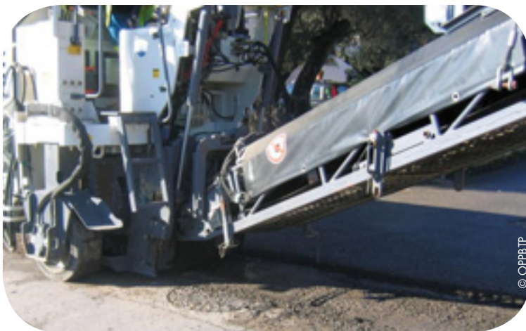
Collecte des agrégats par tapis protégé et évacuation vers une benne.
