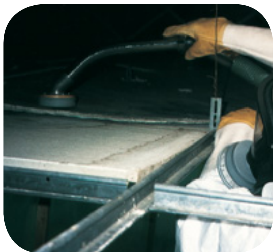
Aspiration de la face supérieure avant dépose de la plaque.
