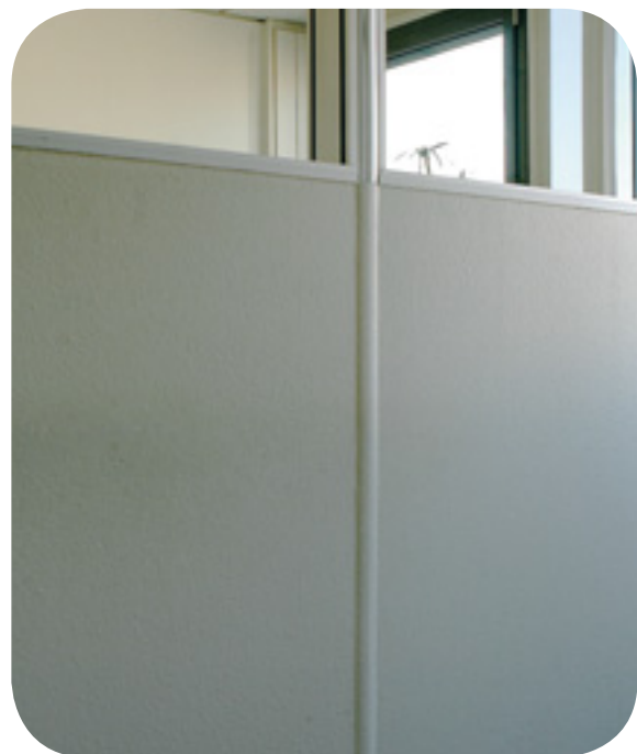
Cloison en amiante-ciment.
