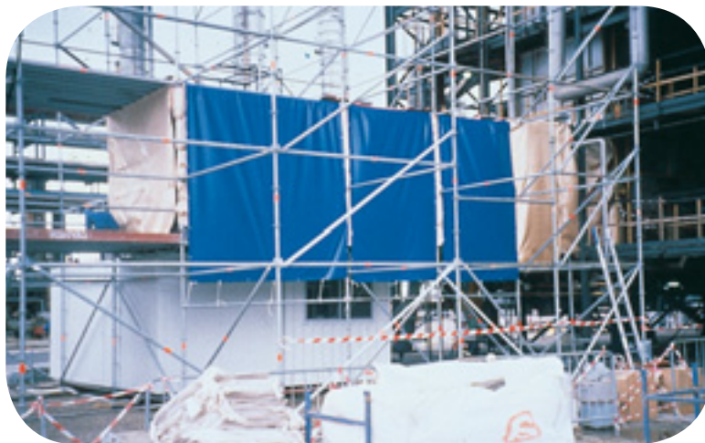
Confinement à l'extérieur d'une installation industrielle.
